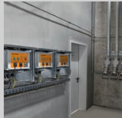
Die Haarup Silo Control sichert gegen Überfüllung und Überdruck im Silo.
