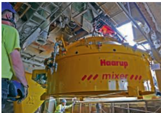
Modernisierung der Anlage mit einem neuen Haarp 3000 l Mischer.
