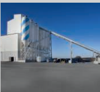
Turmanlage mit 2 Stck. 6000 L Mischer zur Produktion von Transportbeton.
