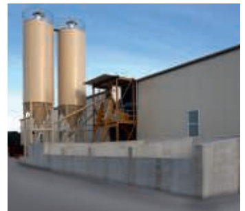
Betonfertigteilefabrik mit Haarup Mischanlage und Tiefsilos.
