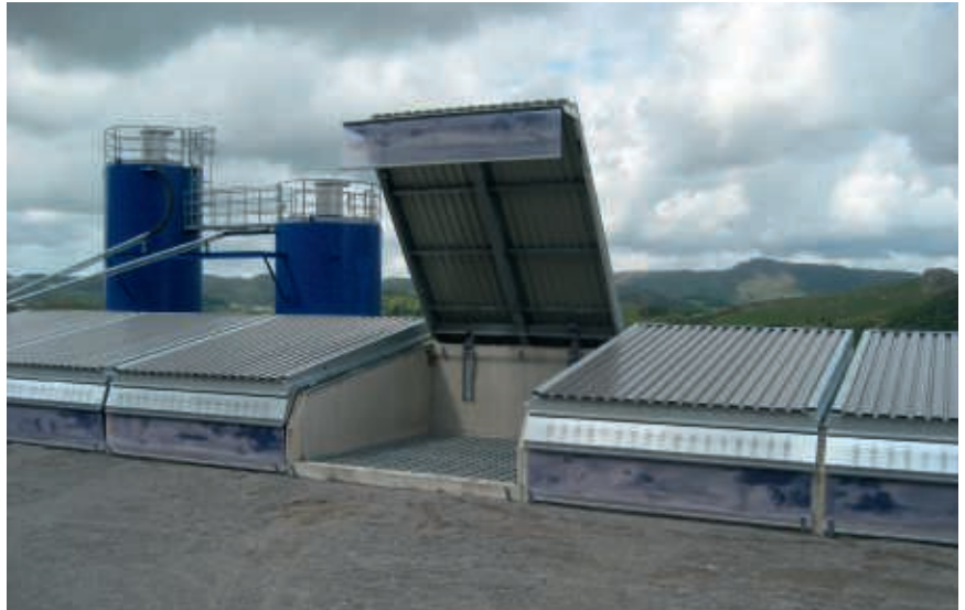
Tiefsiloanlage mit hydraulisch gesteuerter Abdeckung.
