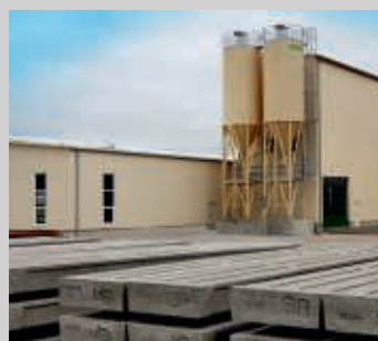
Spaltenbodenfabrik mit kompletter Haarup Dosier- und Mischanlage.
