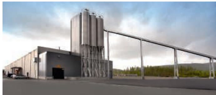
Turmanlage mit 2 Stck. 2250 L Mischer für die Herstellung von Schwellen.
