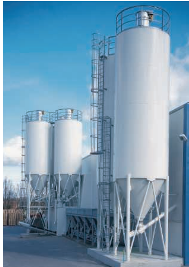
Zementsilos mit feuerverzinkter Leiter, Geländer und Filter mit Druckluftreinigung.
