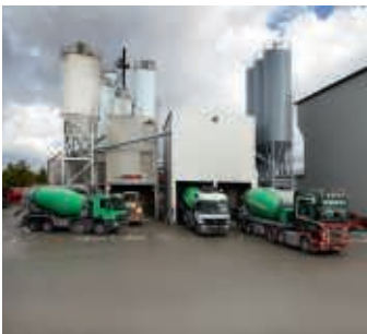
Modernisierung von vorhandener Transportbetonanlage mit Haarup 6000 Liter Mischer.
