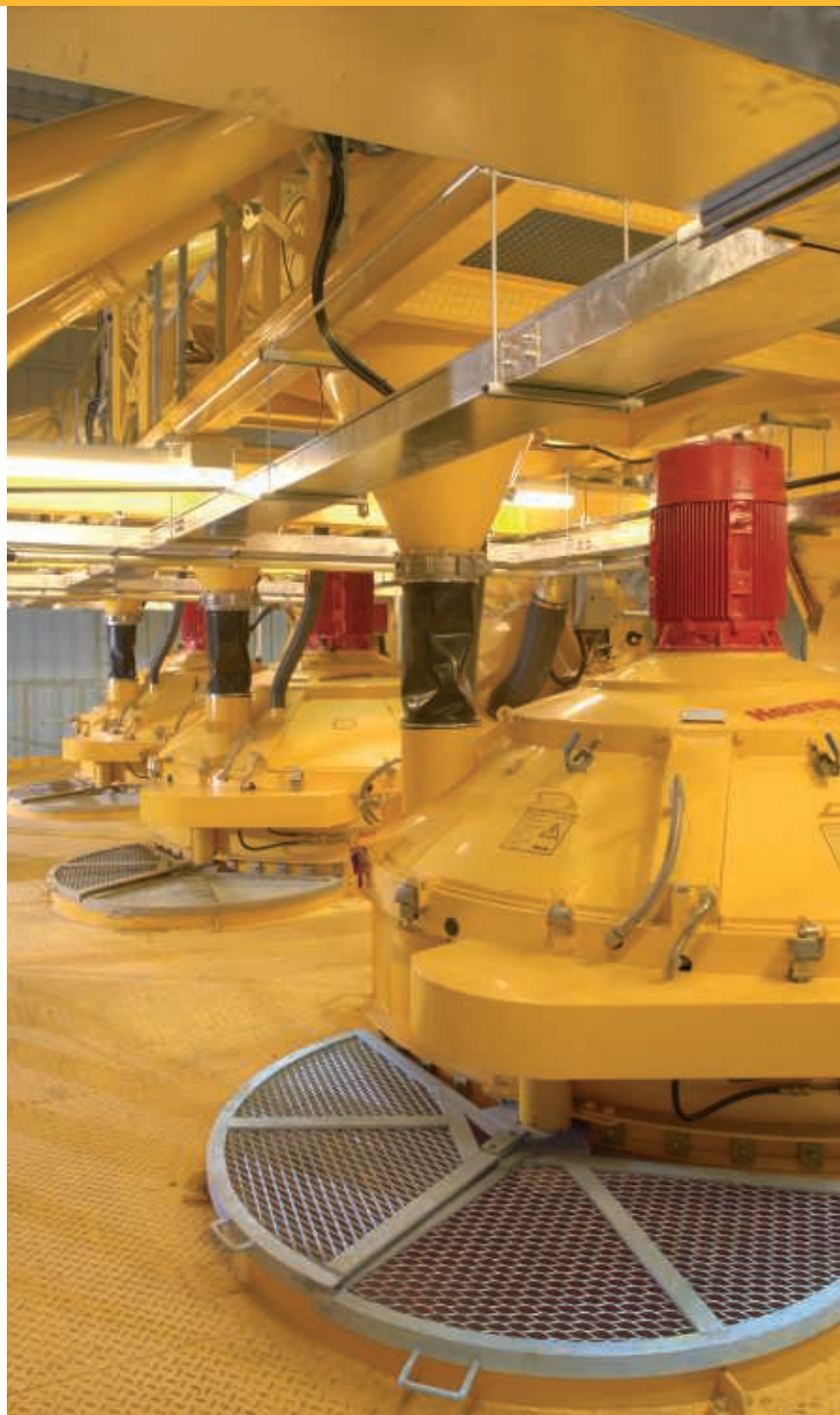
Rohrwerk mit drei 2250 Liter Mischern und Betonkübelwagen.
